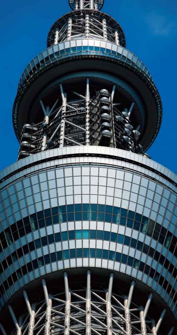
(上) 天望デッキのガラスをはめ込んだアルミカーテンウォールは、強度を保ちながらフレームを細くすることで、開放感と素晴らしい眺望が生まれた (右上) 安全面から展望台の外装材の施工は、塔体の内側から組み立てられた
